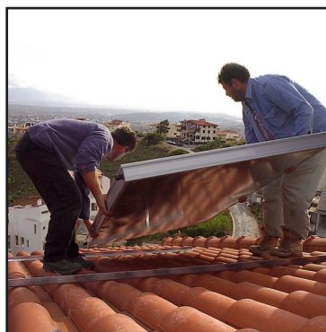
Εικόνα 2: Τοποθέτηση του ηλιακού συστήματος συλλεκτών νερού και ενεργειακού τζακιού 22.000 kcal/h, ως βοηθητικής πηγής ενέργειας, στη διώροφη ηλιακή κατοικία κ. Ουζούνη στο Ντράφι Αττικής [BONAIR, 2010].
