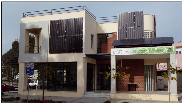
Εικόνα 1: Εγκατάσταση 20 φωτοβολταϊκών συλλεκτών στο Κοινωνικό κέντρο Παγασών του Δημοτικού Οργανισμού Υγείας και Κοινωνικών Θεμάτων (Δ.Ο.Υ.Κ) στον Βόλο. [ENERGIA 2009, Τελευταία πρόσβαση από http://www.energia.gr/article.asp?art_id=32622 ]
