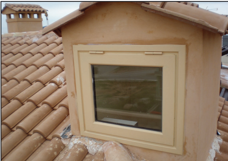
Εικόνα 4: Εφαρμογή αιοθικής καμινάδας, στη βιοκλιματική κατοικία Μισσιακού, 240m 2 , στην Παιανία Αττικής. Η θυρίδα ανοίγει εσωτερικά με ντίζα. Στην κατοικία υπάρχει και ηλιο-γεωθερμικό σύστημα θέρμανσης νερού και χώρων [Κ. Τσίππρας, 2009].
