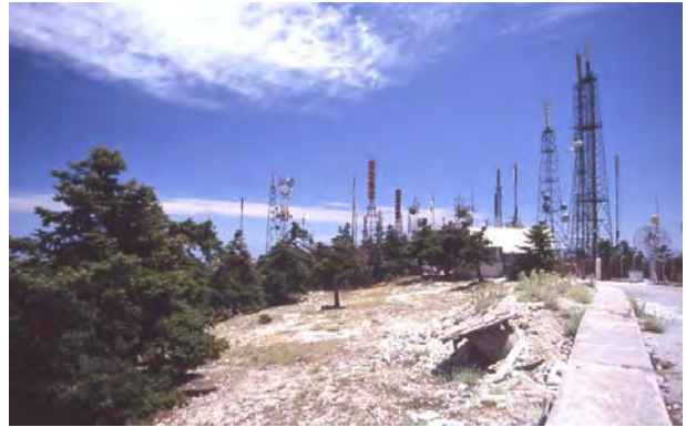
Εικόνα 45. Οι τηλεπικοινωνιακές εγκαταστάσεις στην κορυφή Όρνιο
